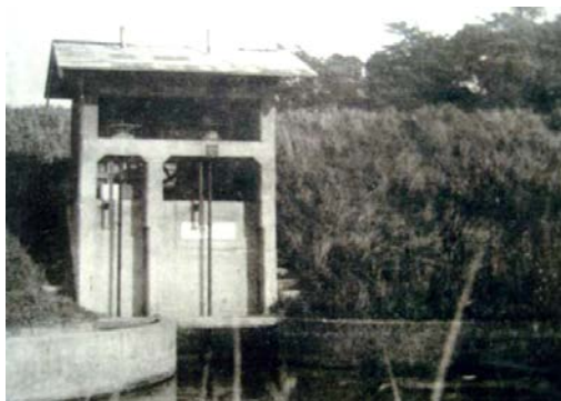
占部用水天白樋門 大正10年
