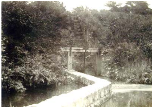
占部用水天白樋門 大正10年
