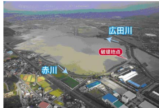
破堤地点と菱池地区の浸水状況
