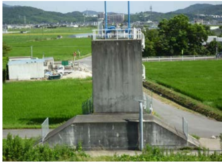
高落吐出樋管 20150902
