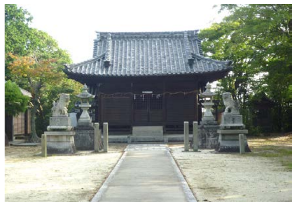
素盞鳴神社本殿 20150726
