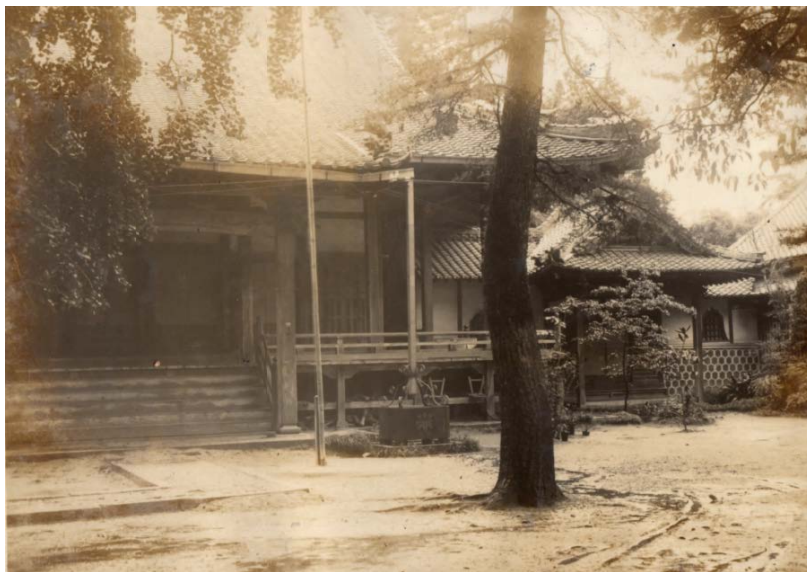
浄光寺本堂 1939(昭和14)年 浄光寺提供
