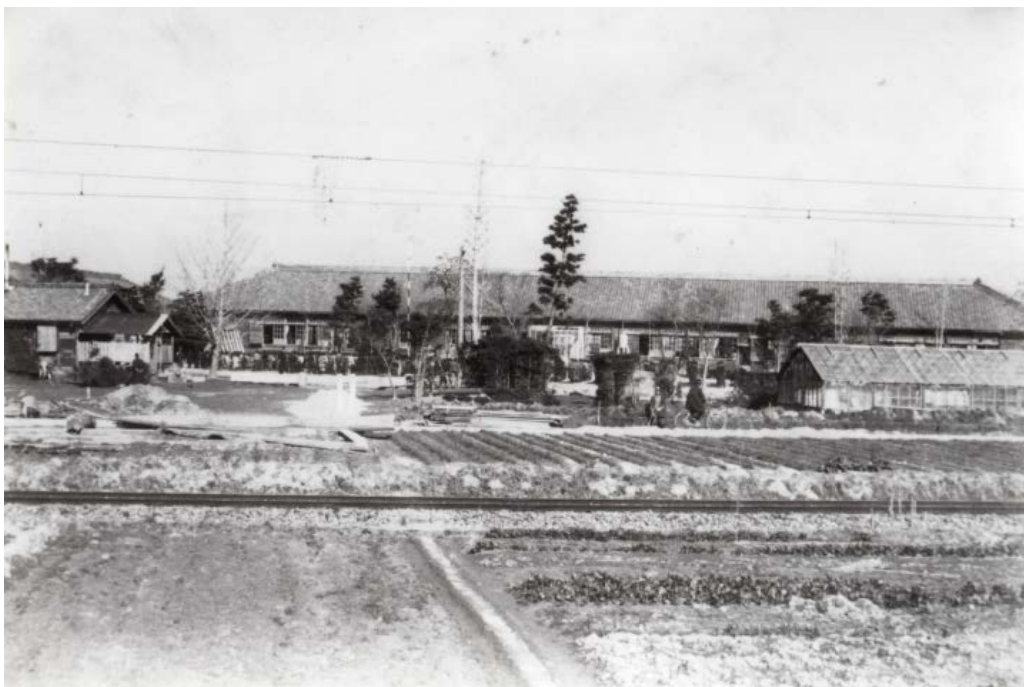
1930(昭和5)年頃 六ッ美第三尋常小学校の前を走る西尾鉄道の線路。 1929(昭和4)年の電化により電柱が見える。現在のJA中島支店から 撮ったもの。正門は現存している。 つるや呉服店提供
