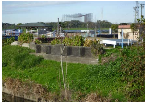
西尾鉄道安藤川鉄橋2 20151209
