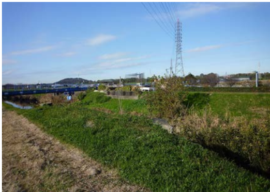
西尾鉄道安藤川鉄橋1 20151209
