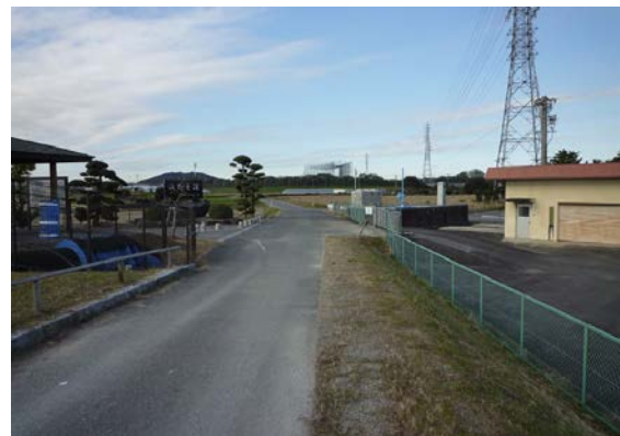
西尾鉄道安藤川鉄橋3 20151209
