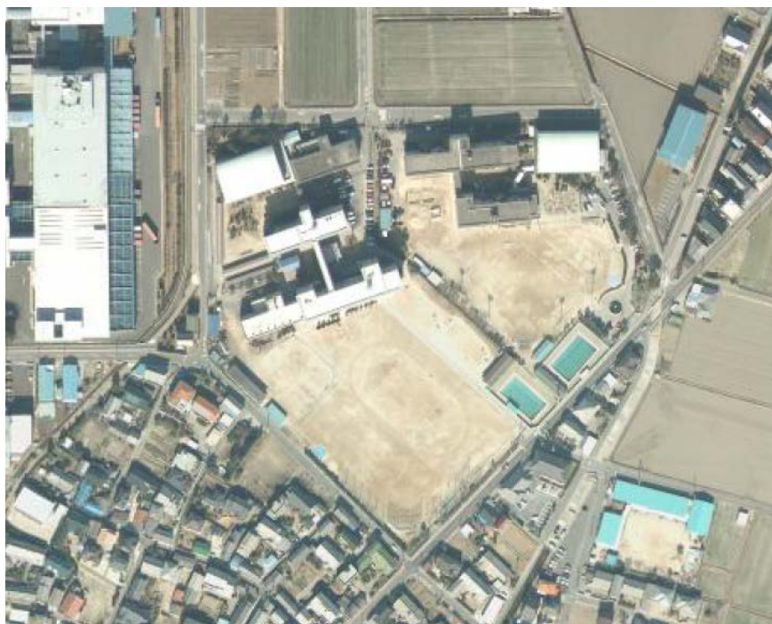
六ッ美中学校航空写真 右側（北東）は六ッ美中部小学校
